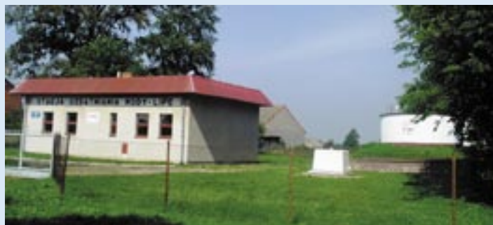
Stacja Uzdatniania Wody w Lipem i w Rychnowie
