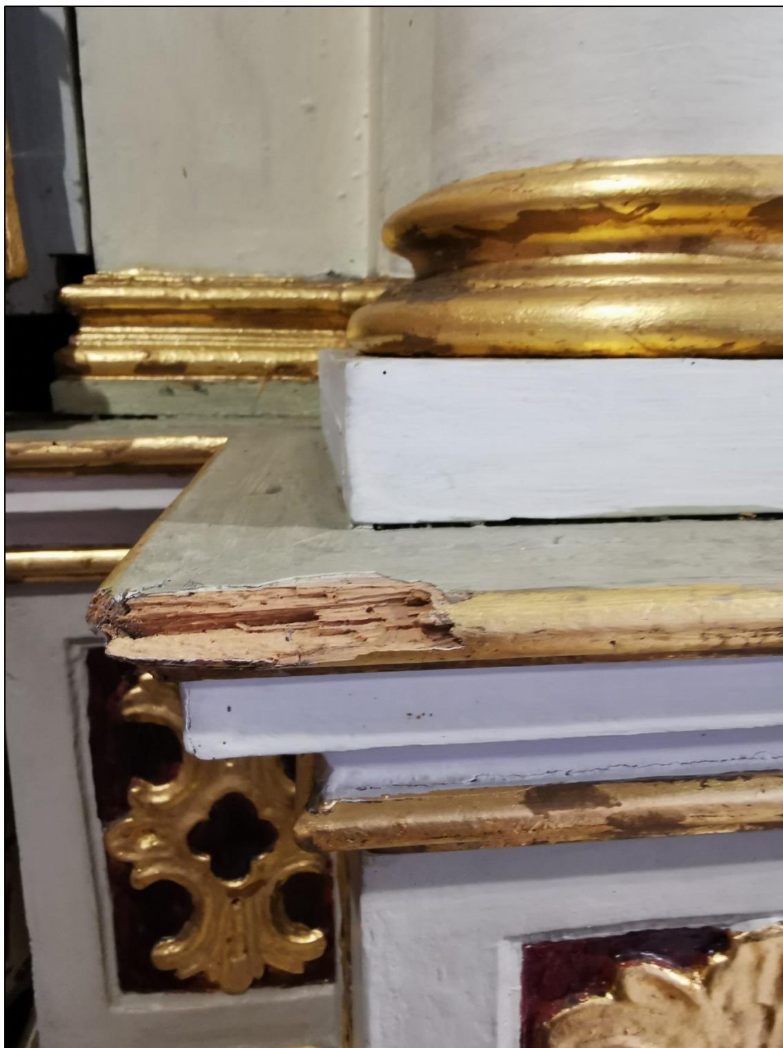
Fot.11. Ołtarz główny p.w. Św. Wniebowzięcia NMP z kościoła p.w. Św. Stanisława Biskupa w Lipem. Fragment predelli. W uszkodzonym fragmencie gzymsu widoczne ślady po żerowaniu owadów.
