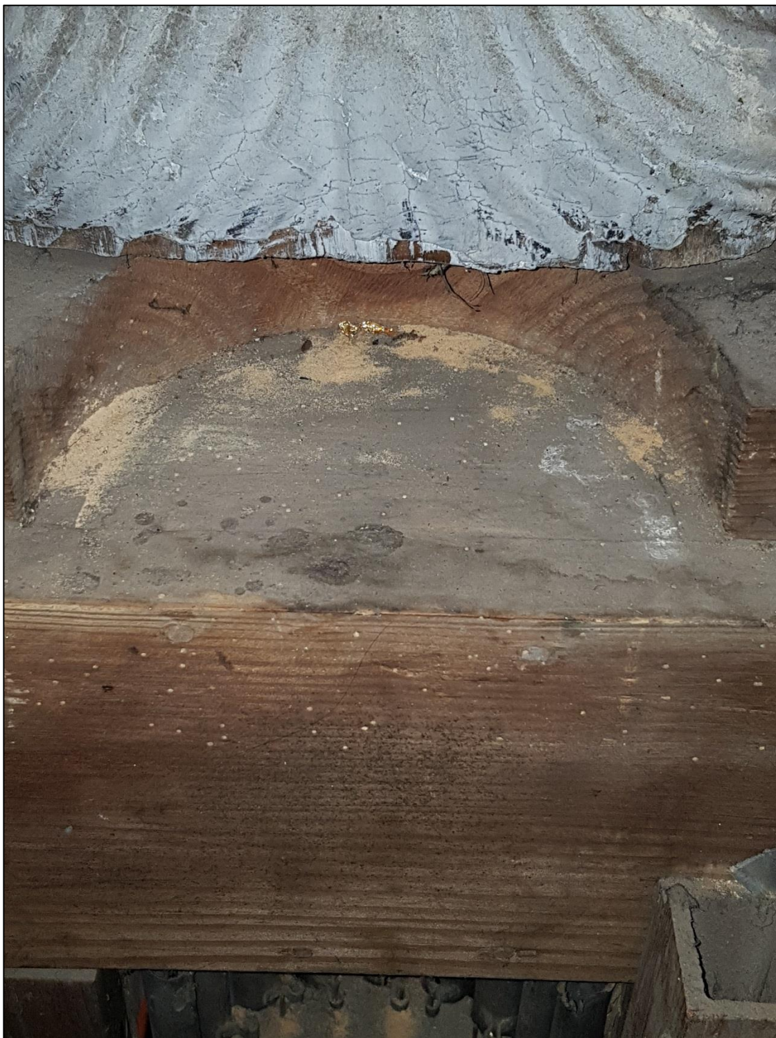
Fot.9. Prospekt organowy z kościoła p.w. Św. Stanisława Biskupa w Lipe. Fragment zwieńczenia, podstawy pod hermą. Wyraźnie widoczne ślady w postaci trocin i otworów wylotowych po żerowaniu drewnojadów.
