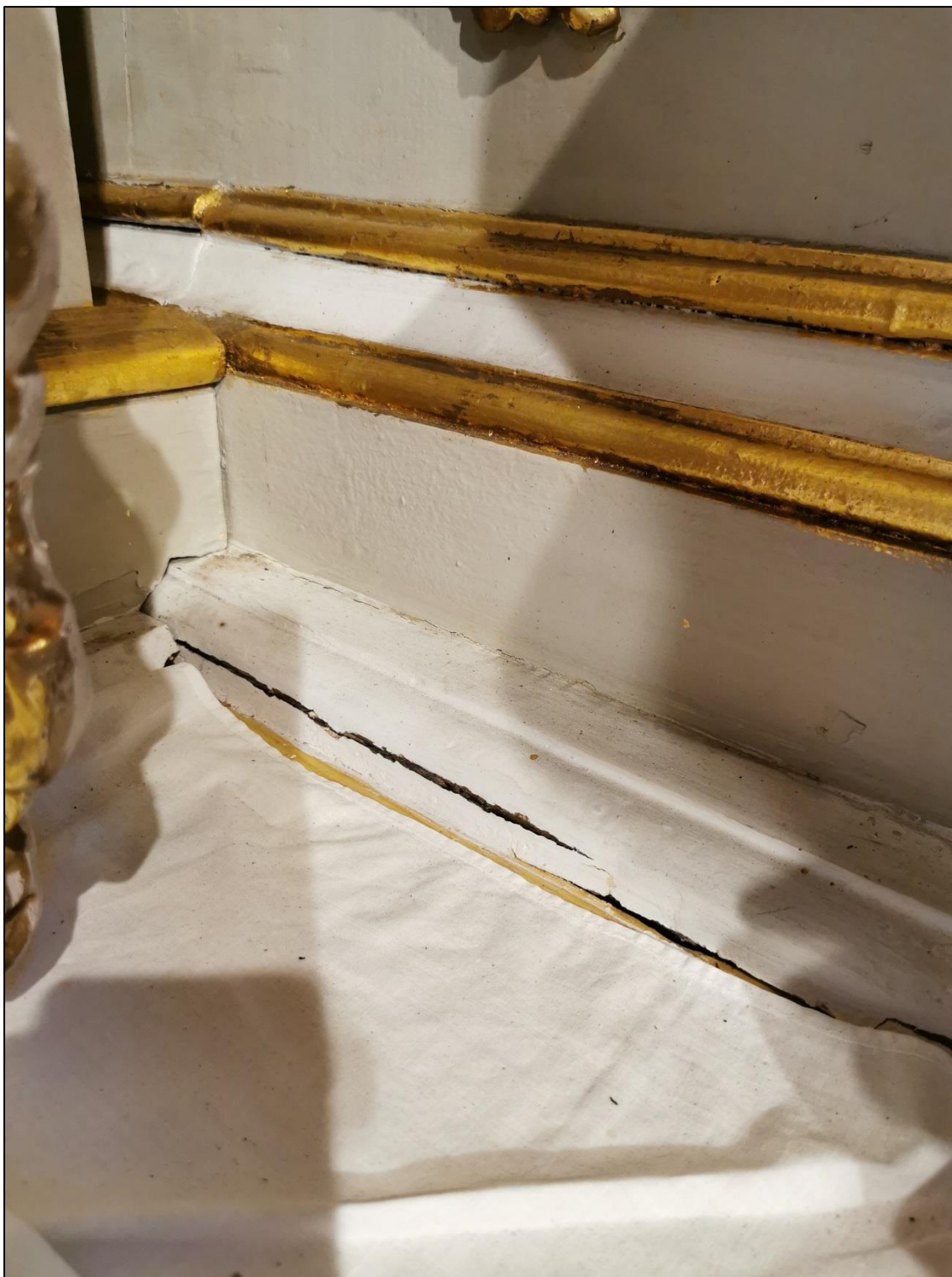
Fot.12. Ołtarz główny p.w. Św. Wniebowzięcia NMP z kościoła p.w. Św. Stanisława Biskupa w Lipem. Podstawa predelli za tabernakulum. Naprężenia materiału spowodowane przeciążeniem, spowodowały pęknięcia elementu podstawy. Na profilach widoczne niechlujne złączenia wykonane szlagmetalem na mikstion.
