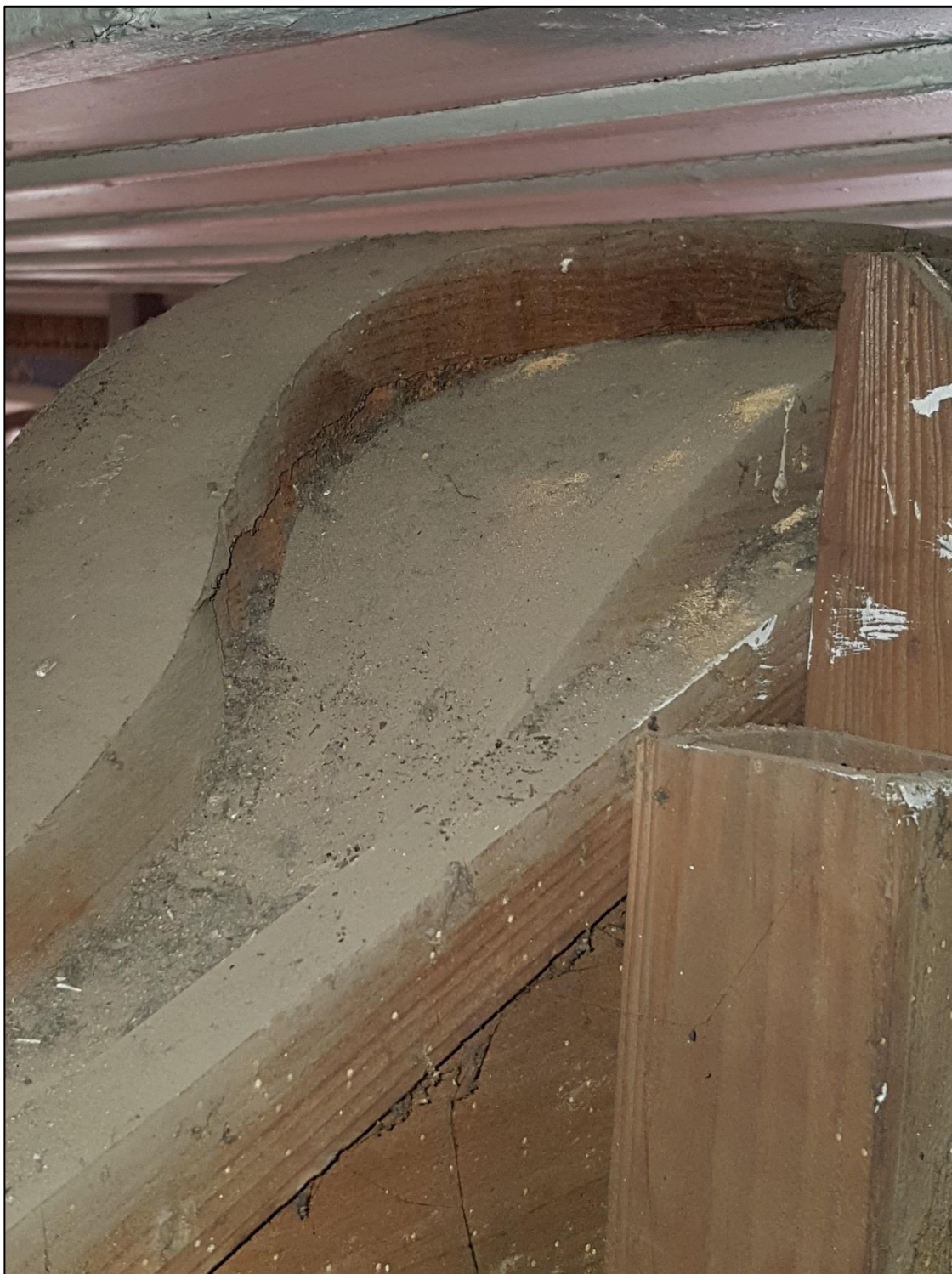
Fot.10. Prospekt organowy z kościoła p.w. Św. Stanisława Biskupa w Lipe. Fragment gzymsu w zwieńczeniu. Wyraźnie widoczne ślady w postaci trocin i otworów wylotowych po żerowaniu drewnojadów.
