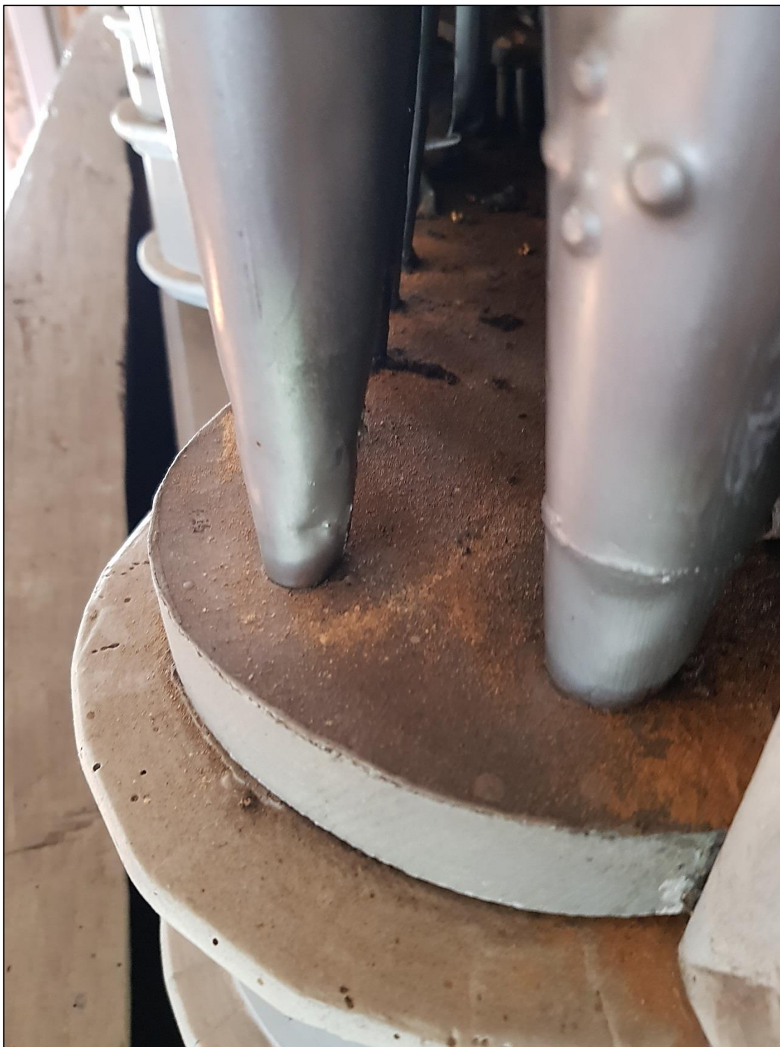
Fot.12. Prospekt organowy z kościoła p.w. Św. Stanisława Biskupa w Lipe. Fragment półokrągłych wiatrownic pod metalowymi piszczałkami prospektowymi. Wyraźnie widoczne ślady w postaci trocin i otworów wylotowych po żerowaniu drewnojadów.
